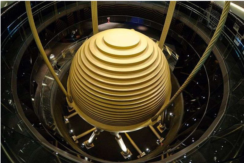
Figuur 6: De tuned mass damper van Tapei 101, een van de hoogste gebouwen ter wereld
